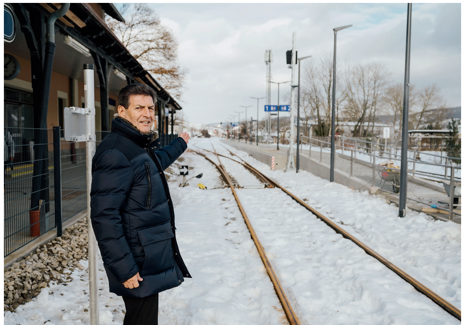
Bürgermeister Harald Leopold besichtigt die Umbauarbeiten am Gleiskörper.
