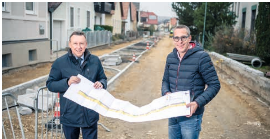
Gemeinderat Martin Nastl und Stadtrat Stefan Nastl besichtigen die Baustelle.
