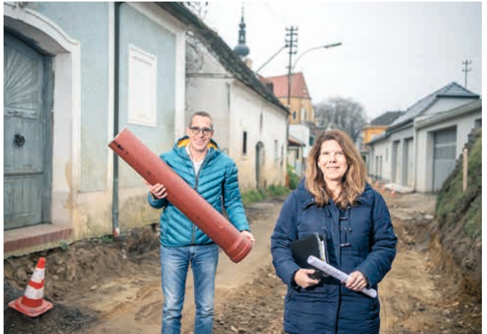
Stadtrat Stefan Nastl und Ortsvorsteherin Andrea Berner sind mit dem Baufortschritt zufrieden.
