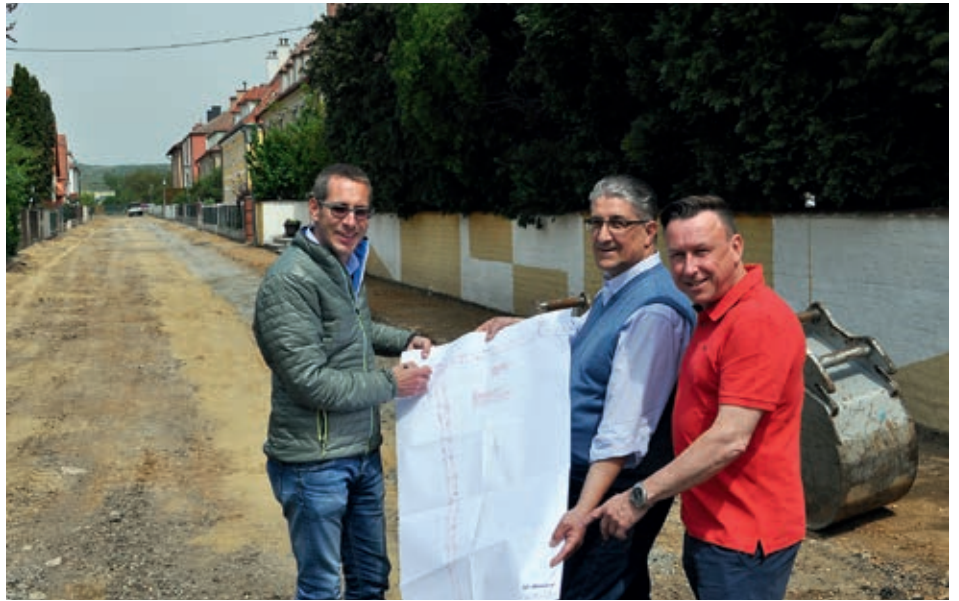
Gemeinderat Martin Nastl informiert sich über den Bauverlauf in Haindorf.
