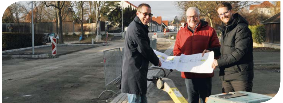
Stadtrat Stefan Nastl, Gemeinderat Gernot Ortner und Bautechniker Rainer Rabl besichtigen die Baustelle.
