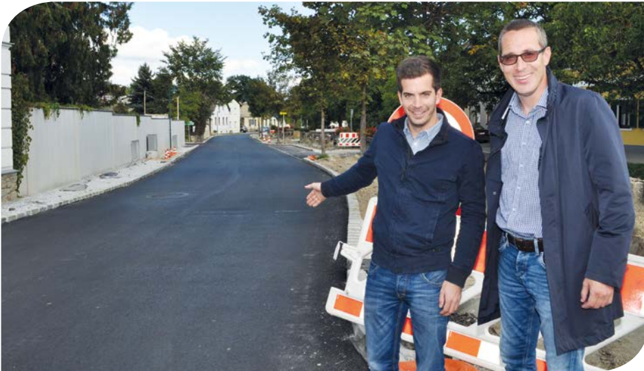
Gemeinderat Alexander Nastl und Straßenreferent Stadtrat Stefan Nastl besichtigen den Baufortschritt.
