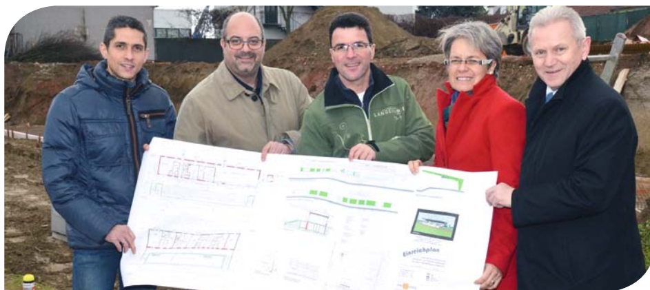
Manuel Kitzler (Planer des Hochbaus), Sportstadtrat Thomas Redl, Obmann des Gesamtsportvereines Gerald Eder, Landesrätin Petra Bohuslav und Bürgermeister Hubert Meisl besichtigen die Baustelle.
