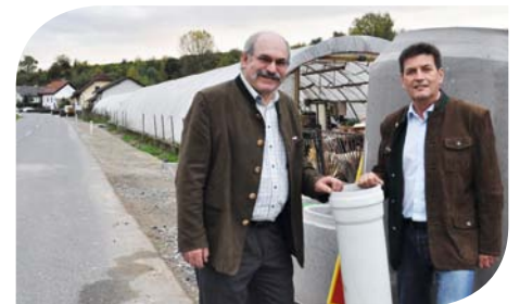
Ortsvorsteher StR. Franz Parth und Gemeinderat Harald Leopold überzeugten sich vom Baufortschritt.
