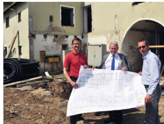
Günter Russegger von der Gedesag mit Bgm. Hubert Meisl und Stadtrat Stefan Nastl bei der Besichtigung der Baustelle.
